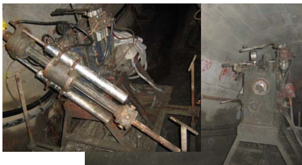
Sondeză S.G. de 150 din galeria perimetrală de injecție.
