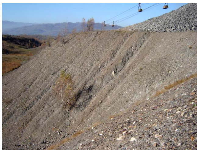
Fig. 2 Forme de eroziune pe taluzurile de haldă
