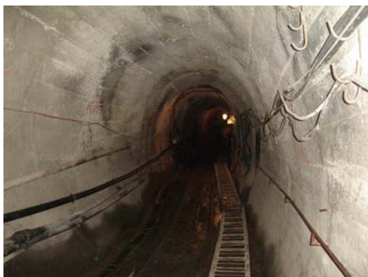
Foto. 1. Galeria perimetrală de injecții Baraj Gura Apelor
