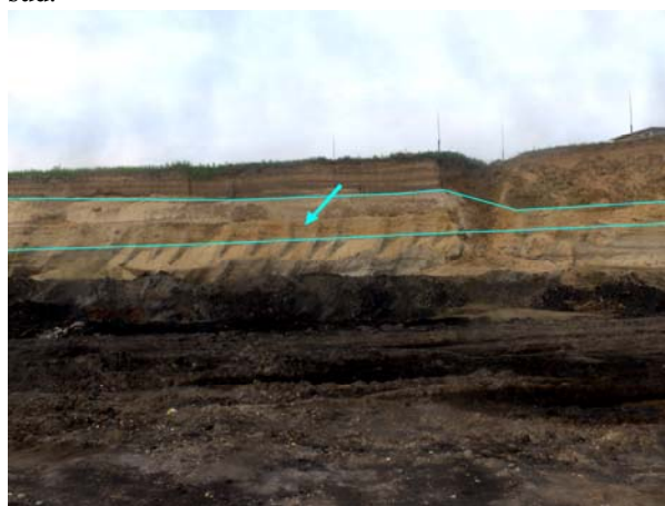
Fig. 2 –Lentila de pietriș în taluzul treptei I
