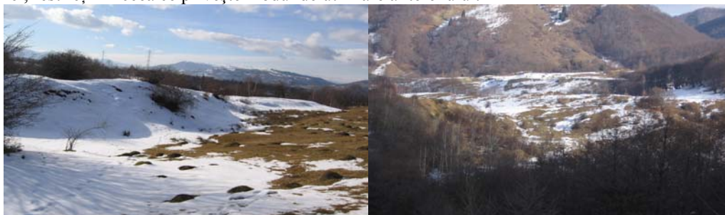
Fig. 3. Fenomen de subsidență în perimetrul minier Lonea
