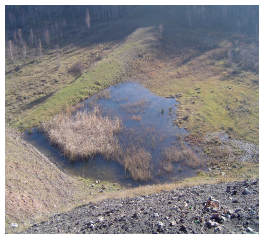
Fig. 5. Acumulare de apă între ramurile haldelor, Petrila
