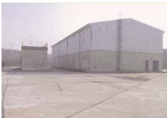
Fig. 5. Depozitul Intermediar de Deșeuri Radioactive
