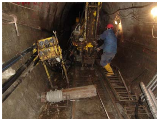
Foto. 2. sonda poziționată pe șirul C-axial din galeria de injecții
