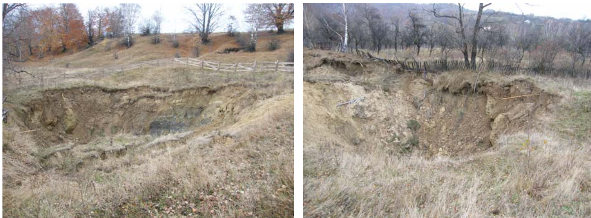
Figura 5. Fenomenul de subsidență discontinuă apărut în perimetrul minier Lupeni 2010
