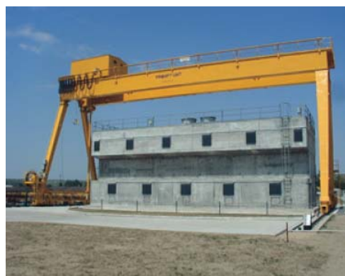
Fig. 6. Depozitul Intermediar de Combustibil Ars
